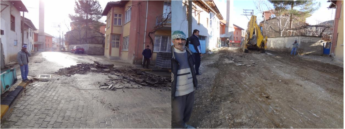
Gazi Caddesi Parke Taşı döşenmeden önceki hali
