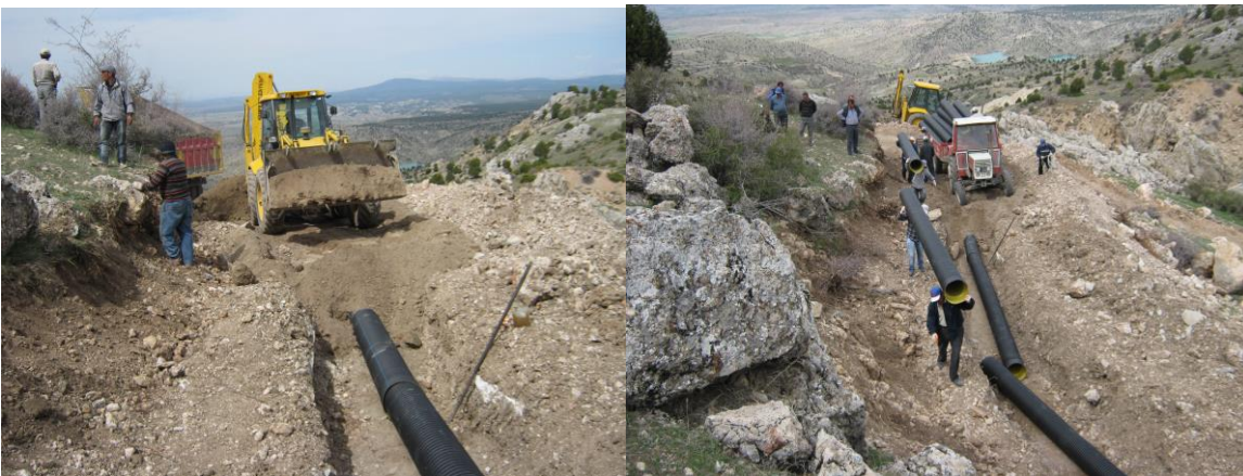
Kazancı suyu Belen Arık'ın Kapalı Sistem Boru döşemesi
