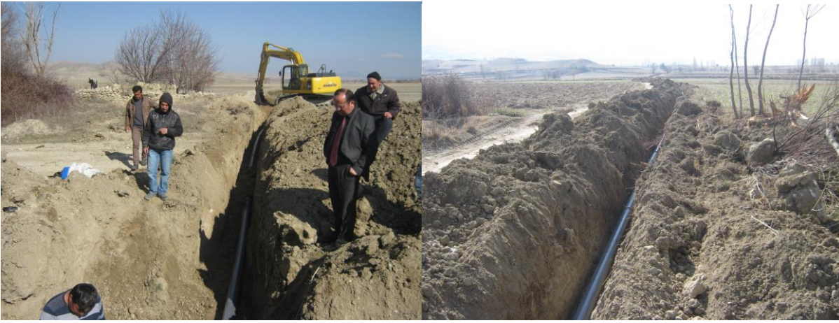
Müsellim Göleti Kapalı Sistem Boru döşeme
