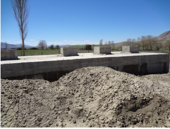
Belediye Arıtma Tesisisi
