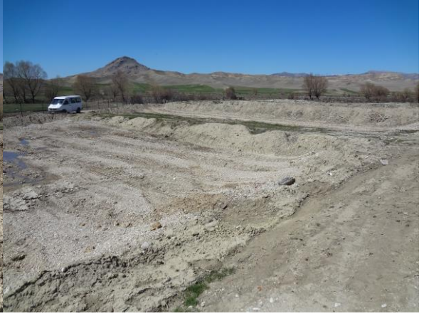
Belediye Arıtma Tesisisi
