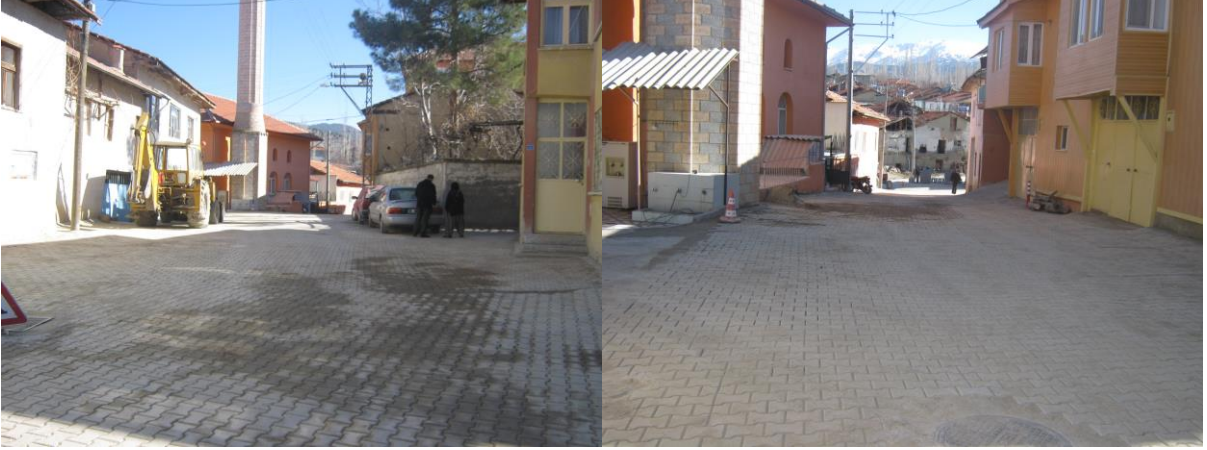
Gazi Caddesi Parke Taşı döşenmiş hali
