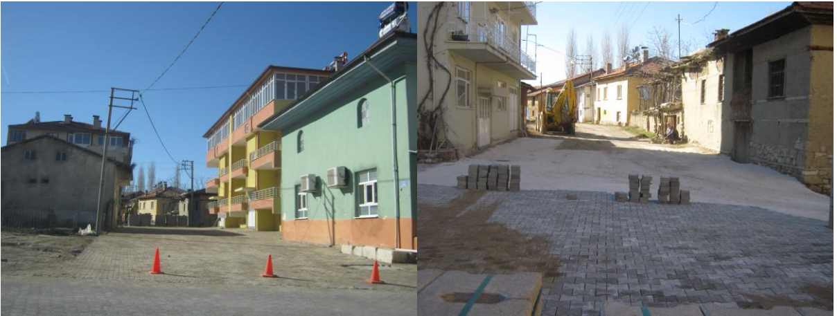
Gökali Sokak yolunun Parke taşı döşemesi
