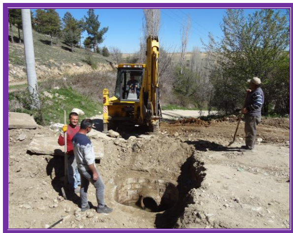
Kanalizasyon arızasının giderilmesi
