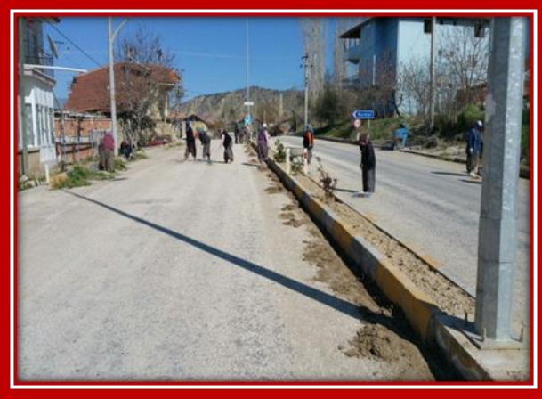
İlçemiz İçerisindeki Yolların Temizlenmesi
