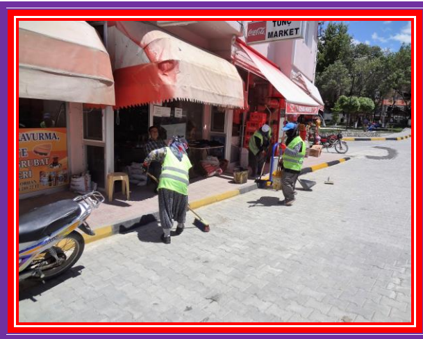
İlçemiz İçerisindeki Bordür Taşların boyanması
