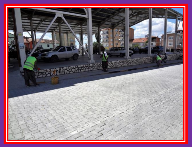
İlçemiz İçerisindeki Bordür Taşların boyanması
