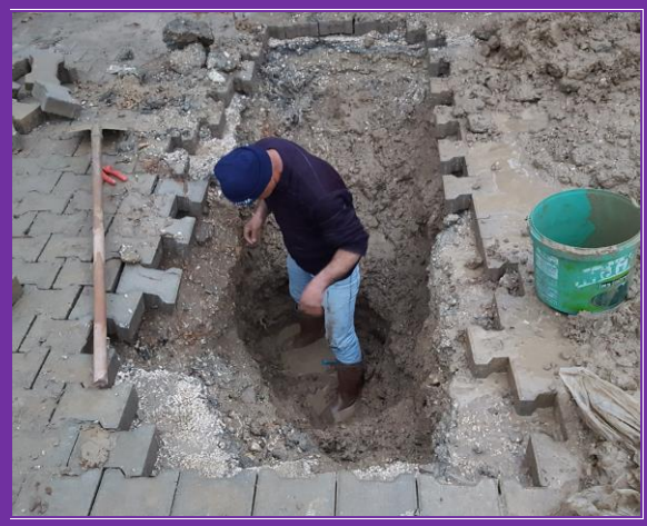
İçme suyunun arızasının giderilmesi
