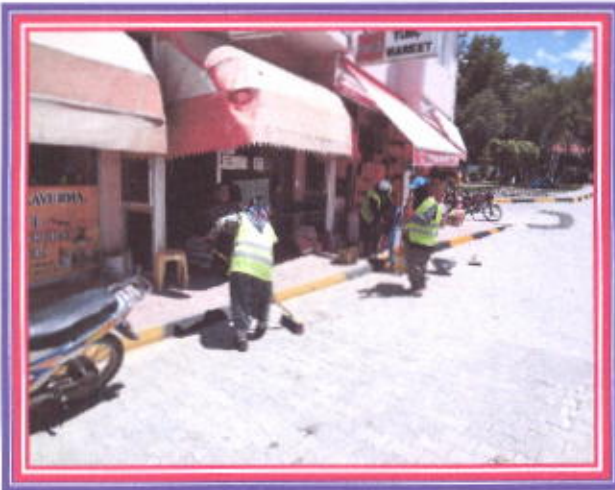
İlçemiz İçerisindeki Bordür Taşların boyanması
