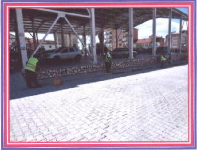
İlçemiz İçerisindeki Bordür Taşların boyanması
